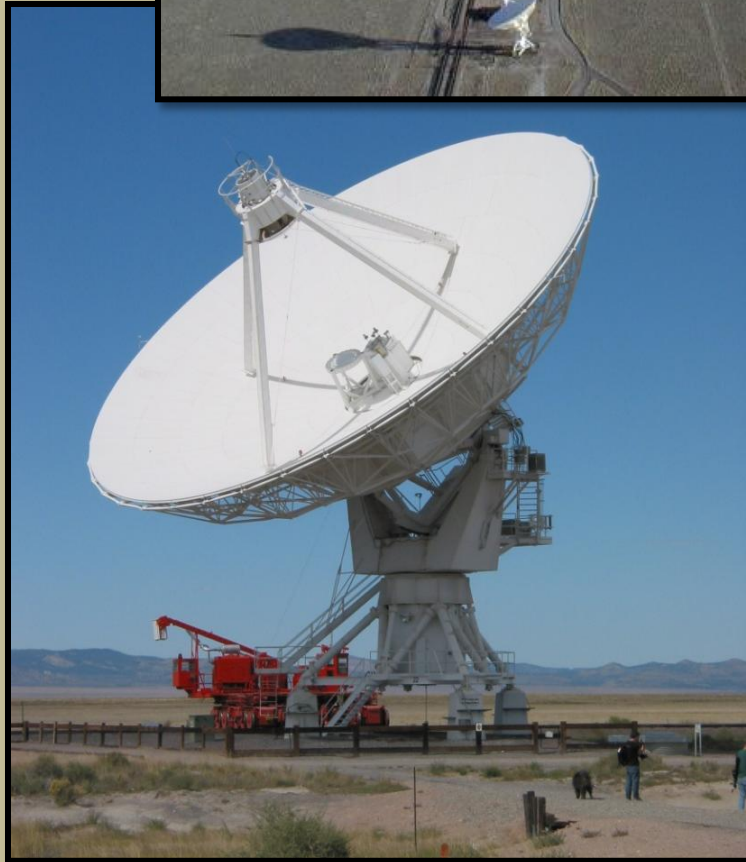
Karl G. Jansky Very Large Array (VLA) 27 antenas de 25m de diâmetro Novo México, EUA
